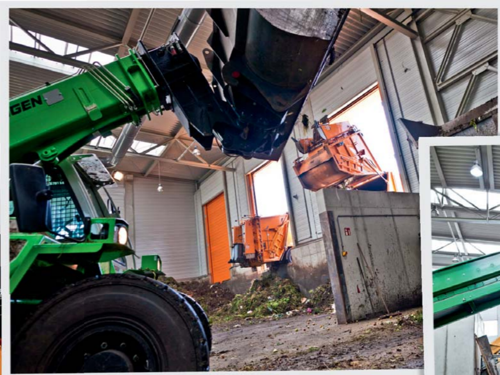
BAGGER SCHAUFEN DEN MÜLL AUF FÖRDERBÄNDER.
