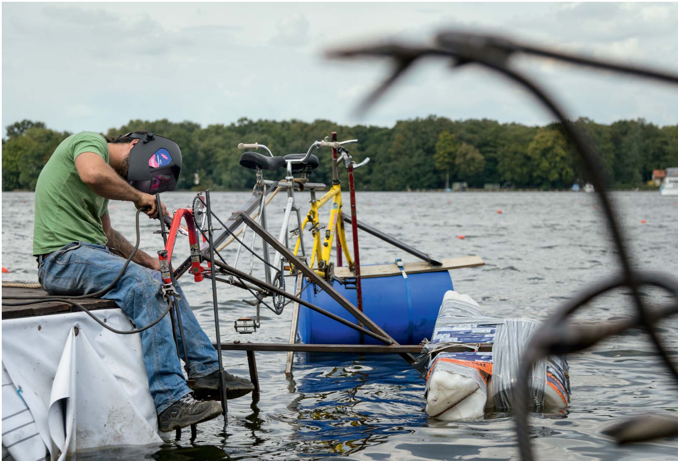
Am „Delphin“ wird gerade die Antriebsflosse festgeschweißt. Nützte aber nichts: Bei der Regatta verkeilte sie sich und brachte das italienische Team zum Erlahmen.
